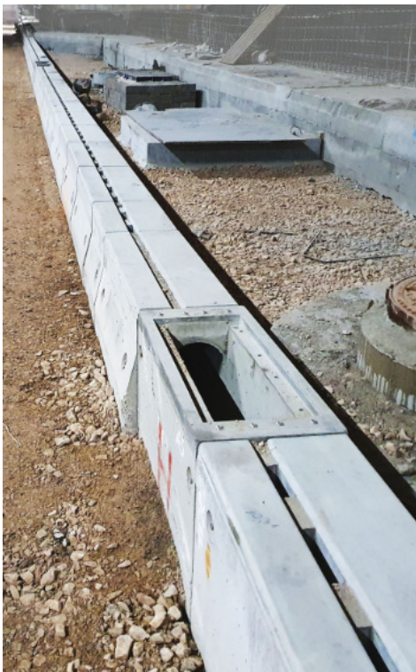
Tunel S2 Warszawa AS-S200 K-T
