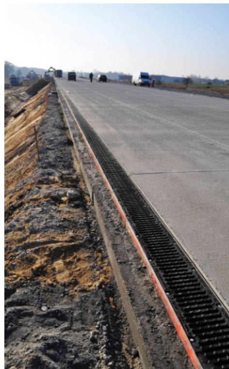
Droga Ekspresowa S8 Zawada AS-200 - 900mb
