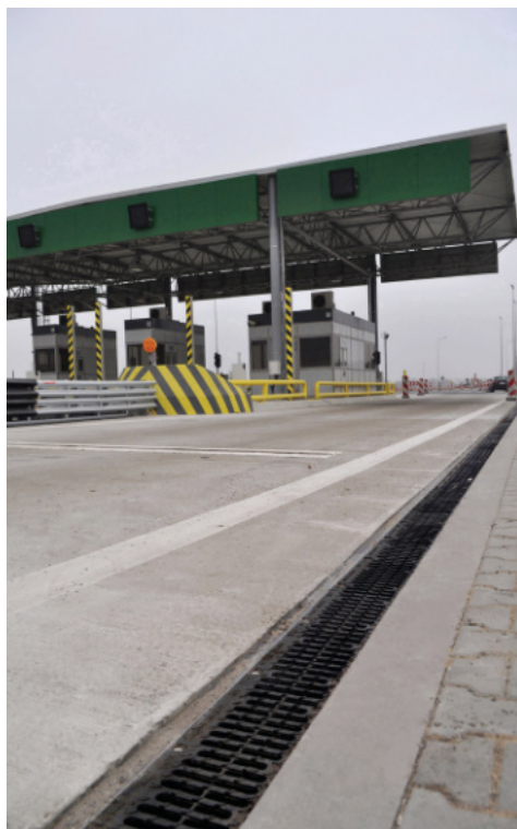
Autostrada A2 Buk AS-150
