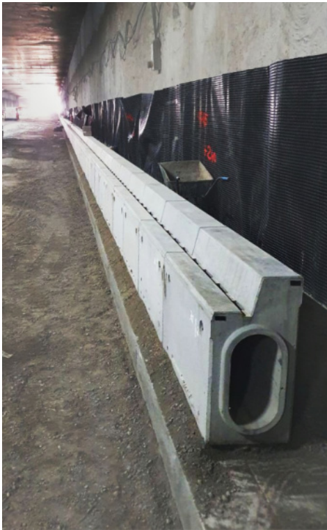
Tunel S2 Warszawa AS-S200 K-T
