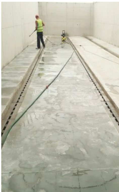
Zakład unieszkodliwiania odpadów Katowice AS-S100 N-0 - 4020 mb
