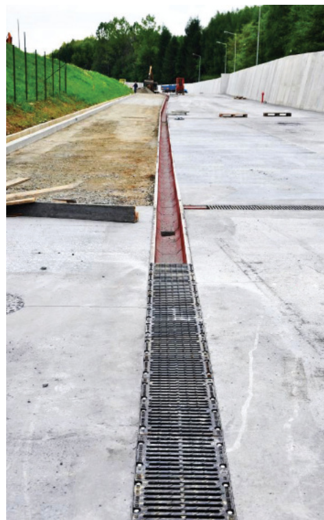
Składowisko Odpadów Komunalnych Barycz AS-300 - ponad 700mb
