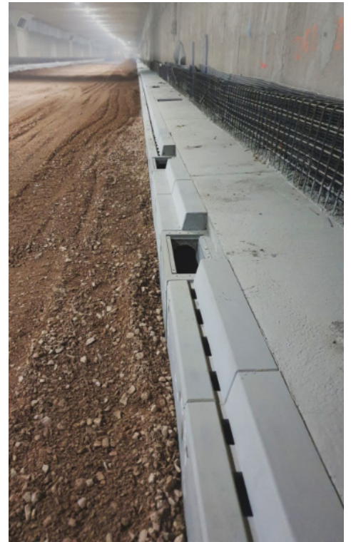
Tunel S2 Warszawa AS-S200 K-T
