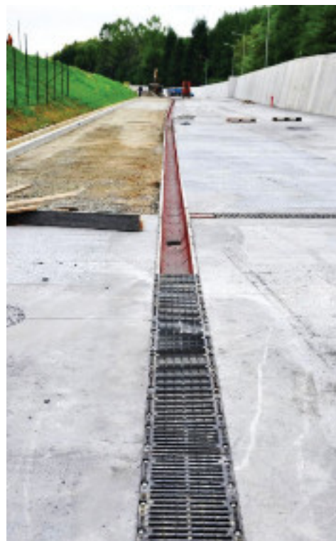
Składowisko Odpadów Komunalnych Barycz AS-300 - ponad 700mb
