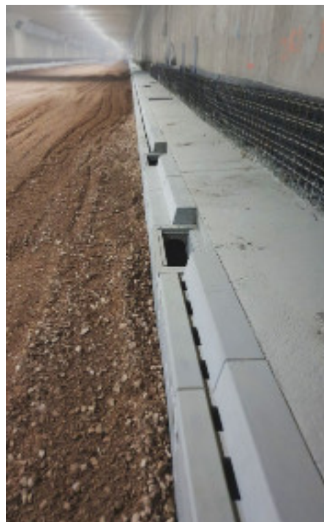
Tunel S2 Warszawa AS-S200 K-T
