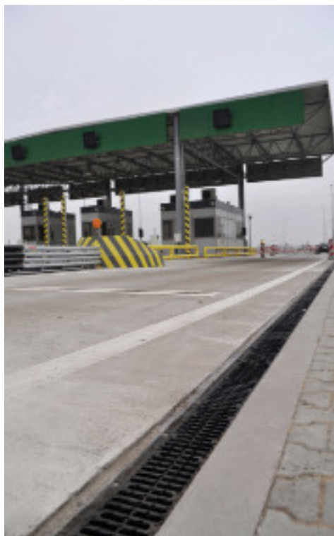
Autostrada A2 Buk AS-150
