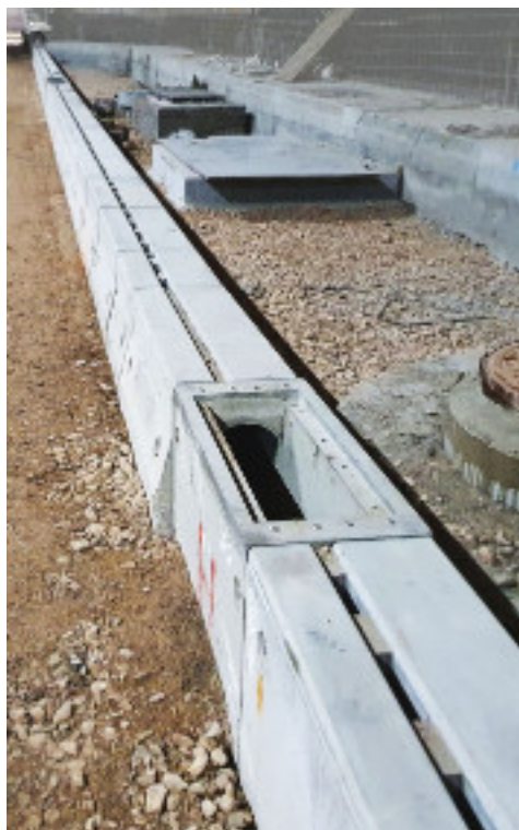
Tunel S2 Warszawa AS-S200 K-T
