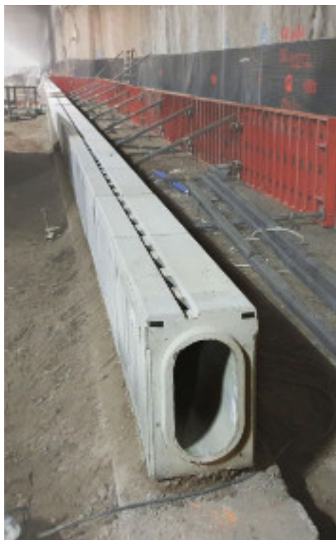
Tunel S2 Warszawa AS-S200 K-T
