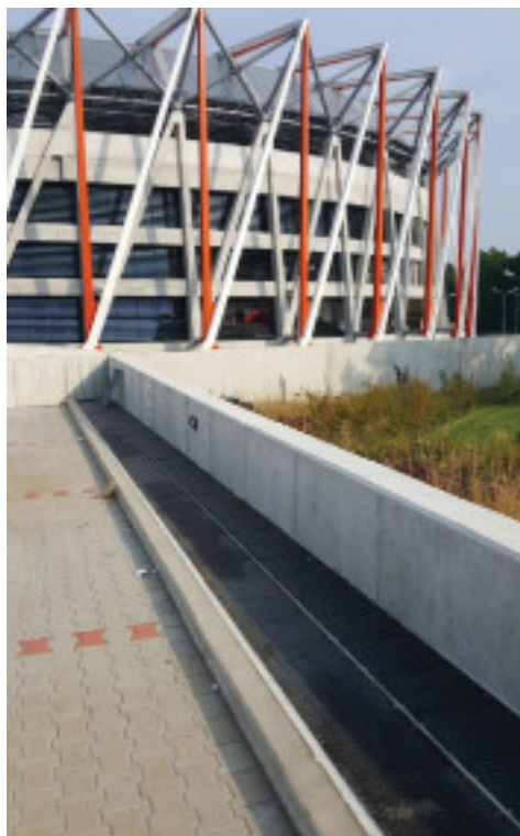
Stadion Miejski Białystok Kanały instalacyjne AS-300 z pokrywą żeliwną
