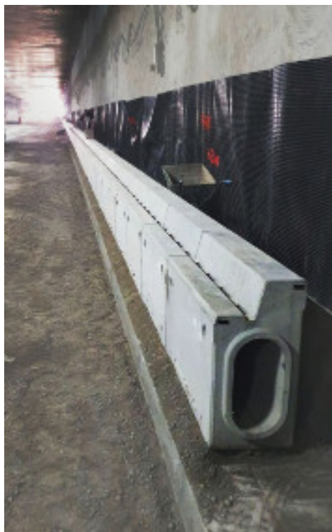
Tunel S2 Warszawa AS-S200 K-T
