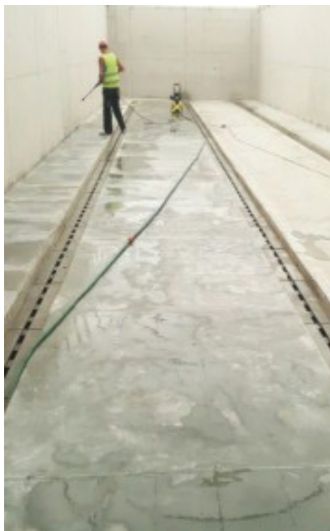
Zakład unieszkodliwiania odpadów Katowice AS-S100 N-0 - 4020 mb
